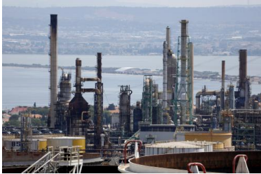
La raffinerie de Total à La Mède (Bouches-du-Rhône) devenue en juillet 2019 « bioraffinerie » © Reuters
