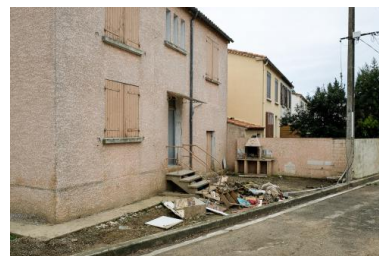
Maisons endommagées et abandonnées suite aux inondations des 14 et 15 octobre 2018 dans le quartier de l'Aiguille à Trèbes. © Olivier Saint-Hilaire
